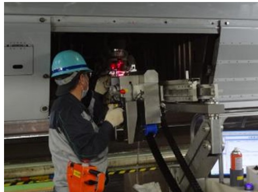
スパイラル走査式探触子挿入
